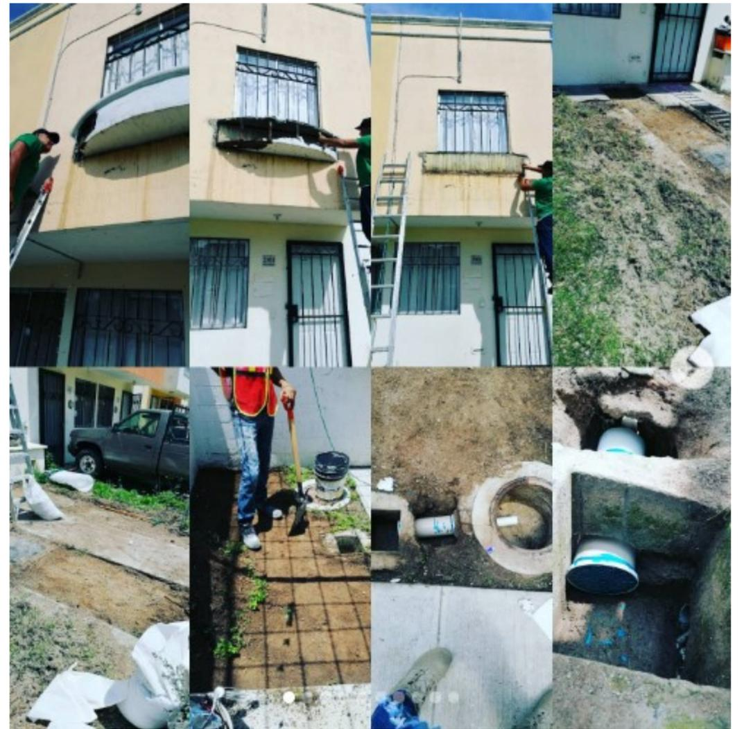
Trabajo terminado: Retiro de moldura exterior, reparación de fachada, pintura de fachada, suministro e instalación de drenaje para jardín, suministro e instalación de pasto en patio y cochera.
