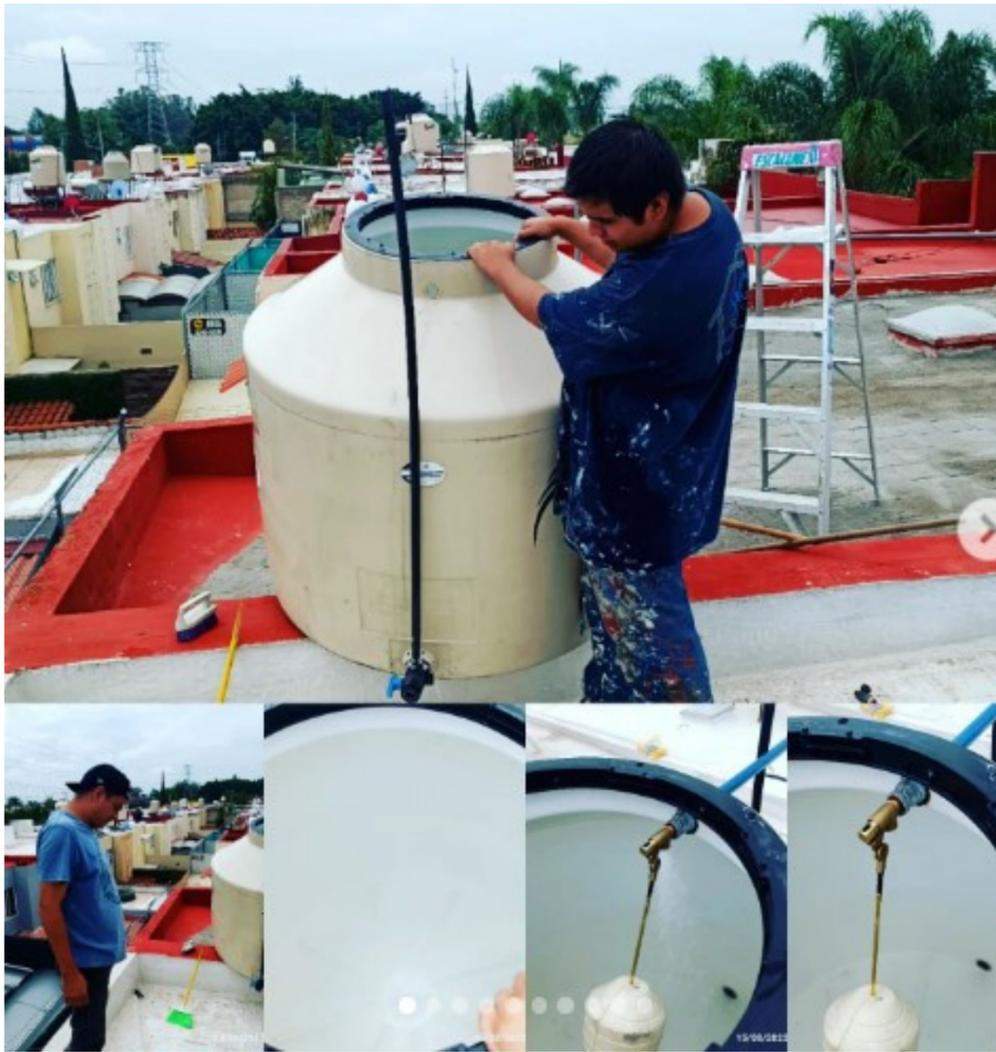
Limpieza de tinaco, Suministro e Instalación de válvula de llenado, flotador y tubería. Instalación de tubería de tinaco a calentador solar.
